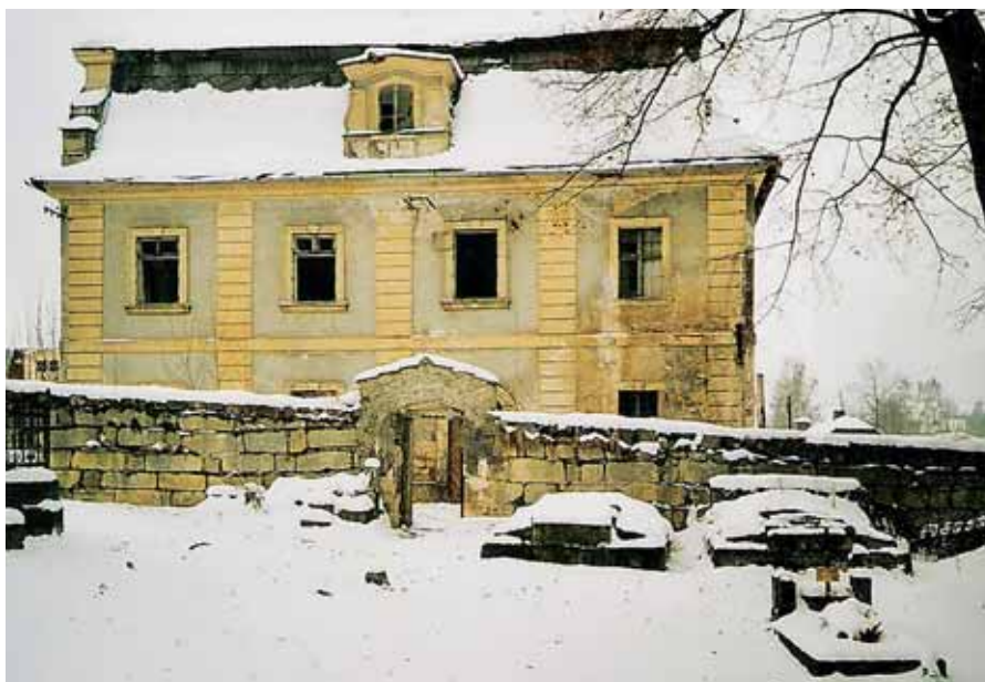
Budova bývalého římskokatolického farního úřadu v Šonově u Broumova č. p. 89 (pohled ze hřbitova). Stav v listopadu 2005. Foto: autor
